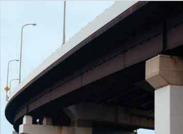
Sanpo-Nyuro Köprüsü (Osaka) Fotoğraf: Mart 2010 (Yapımından 28 Yıl Sonra)
